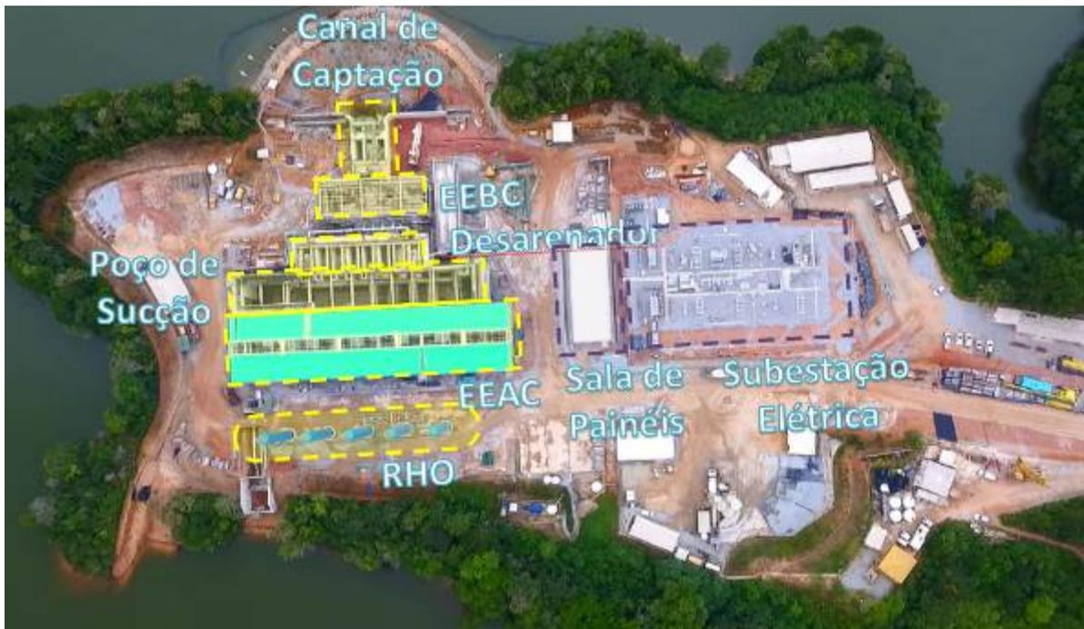
Figura 2 – Visão Geral das Unidades componentes do Complexo do Sistema de Captação de Água Bruta do Sistema Produtor São Lourenço na Represa Cachoeira do França.
