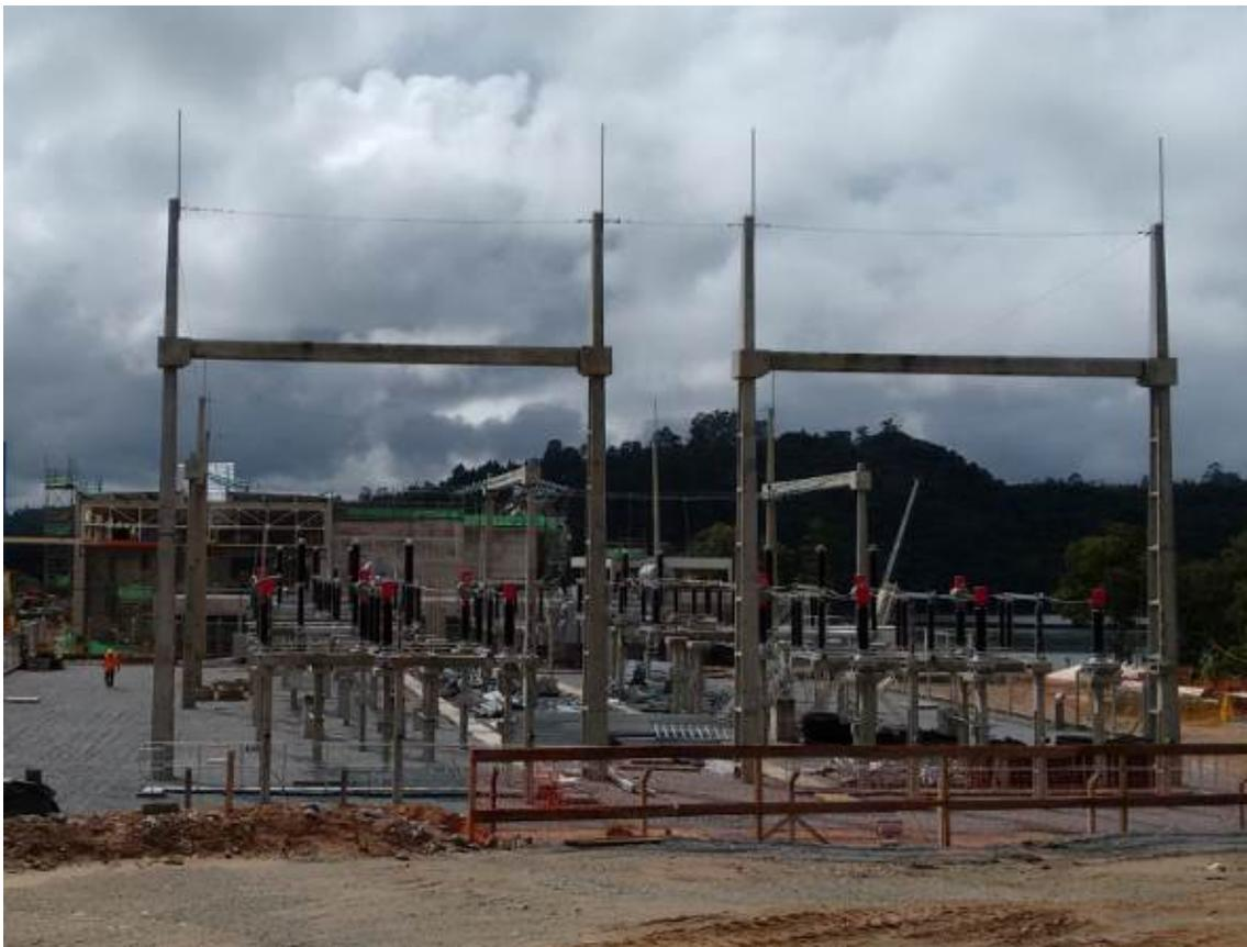
**Figura 10 – Vista da Montagem da Subestação – 2 Transformadores de 35 MVA / 138KV**
