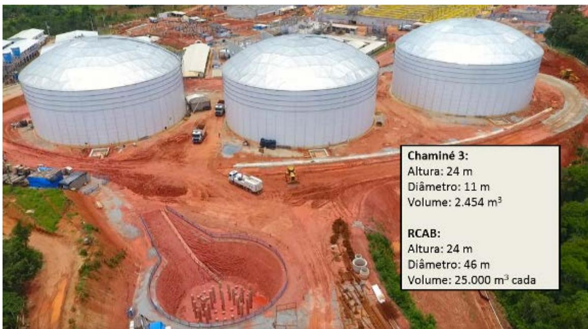
Figura 29 – Chegada da água bruta na ETA e os três Reservatórios de Compensação de Agua Bruta.
