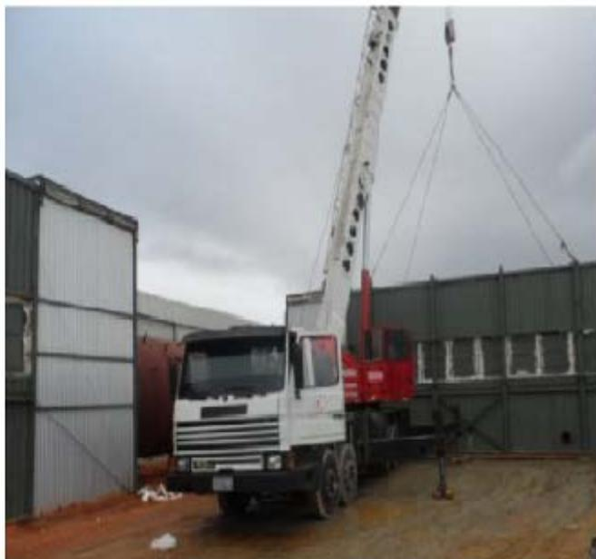
**Figura 14 – Acompanhamento do processo de tratamento térmico, onde verifica-se nesta foto a montagem "in-loco" do alto-forno sobre o vaso de pressão, para alívio das tensões das soldas.**
