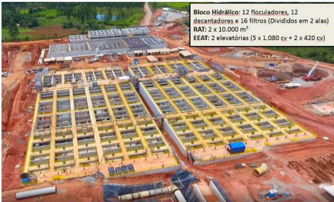
Figura 28 - Vista das do Bloco Hidráulico (Floculadores, Decantadores e Filtros) da Estação de Tratamento de Água Vargem Grande Paulista.
