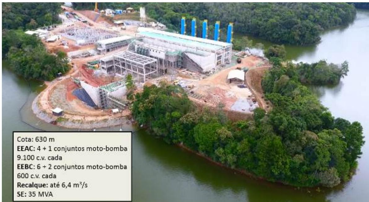
**Figura 1 – Complexo do Sistema de Captação de Água Bruta na Represa Cachoeira do França. Bombeamento para vencer os 330 metros da Serra de Paranapiacaba, com pressões Classe PN 40 inéditos na Sabesp.**
