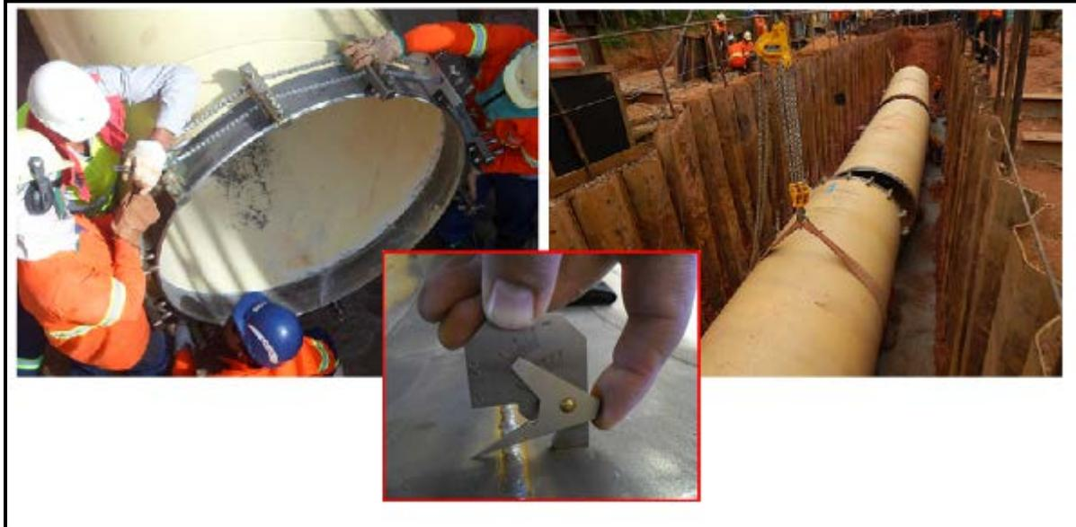
Figura 21 - Verificação de acoplamento e bisel em conformidade com as tolerâncias permitidas na NTS 285 - Sabesp.
