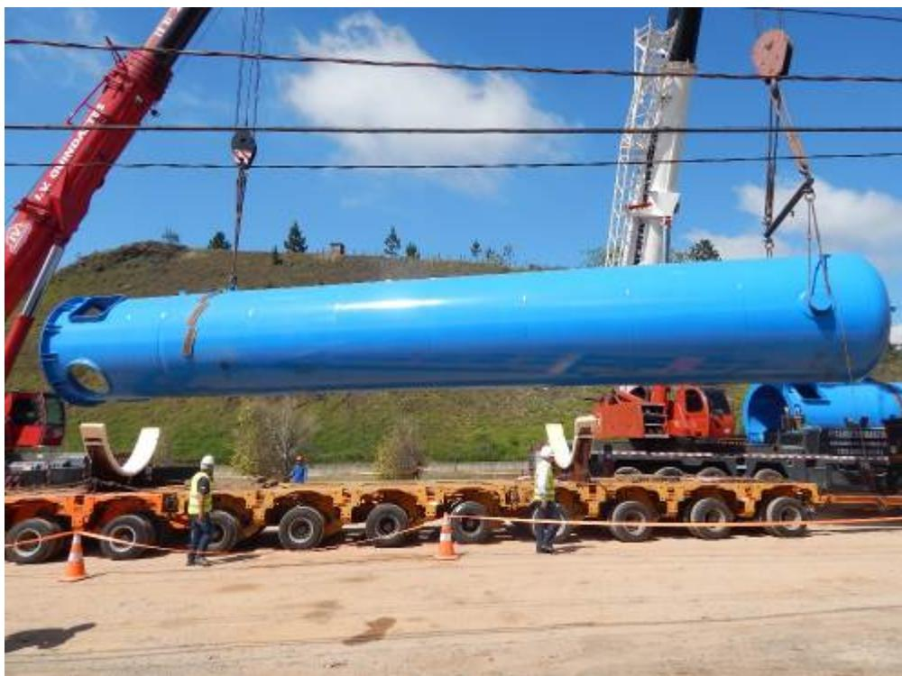
Figura 18 – Logística e transporte dos RHOs onde foi realizado um minucioso plano de locomoção com trucks e linhas de 12 eixos, guindastes e operadores logísticos especializados.
