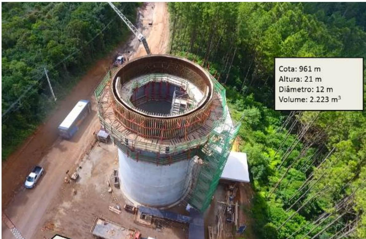
Figura 25 - Chaminé de Equilíbrio 01 - Transição do trecho de recalque para gravidade, instalada no divisor de águas.
