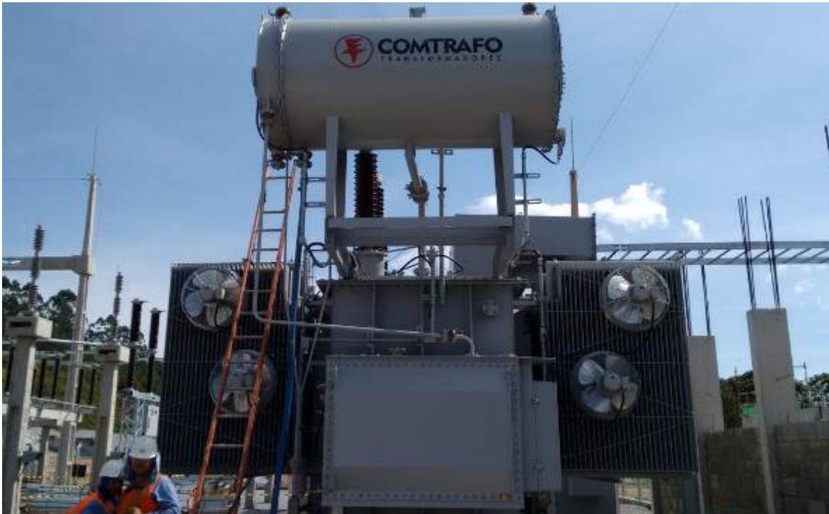
Figura 11 - Instalação e testes dos Transformadores de 35 MVA na SE da Captação de Água Bruta.
