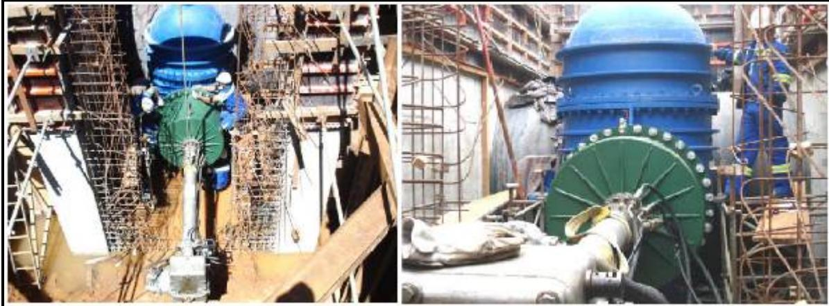
**Figura 30 – Ferramentas de corte do sistema de furação em carga da Superintendência de Manutenção Guarapiranga MM – SABESP, que será utilizada nas interligações do SPSL**
