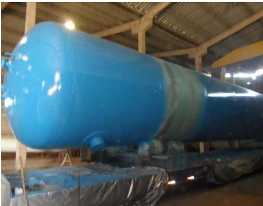
Figura 17 – Processo de aplicação de primer e das camadas conforme esquema pinturas previstos.
